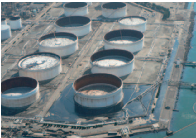
東日本大震災の津波により屋外タンク貯蔵所の配管が破損しタンク内の危険物が流出した状況（仙台市消防局提供）
